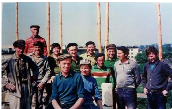
Robotnicy na placu budowy
